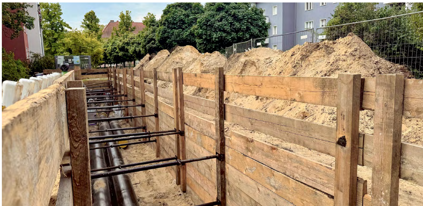
Fernwärmeleitung der BEW im Bau © Rödning | Charlotte
