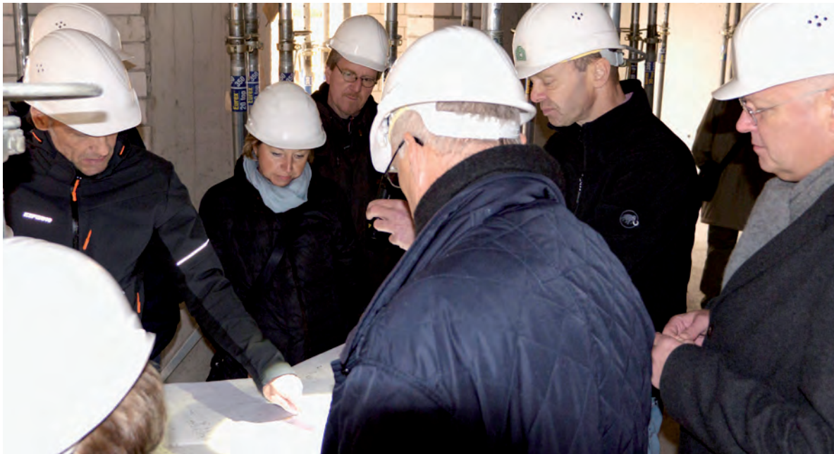
Baurundfahrt Aufsichtsrat- Besichtigung Rohbau in der Cautiusstraße 17/19
