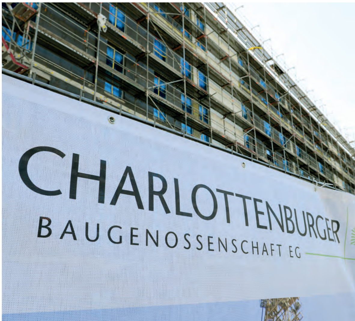
Neubauprojekt „Charlotte am Campus“ in Berlin-Adlershof
