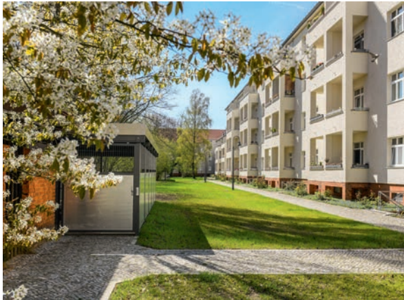
WIE 570/580 | Neugestaltete Innenhöfe im Engelmannweg
