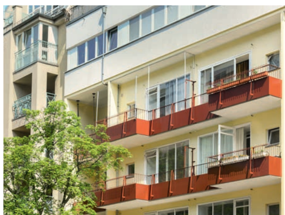
WIE 560 | Sanierte Balkone in der Kohlrauschstraße 1
