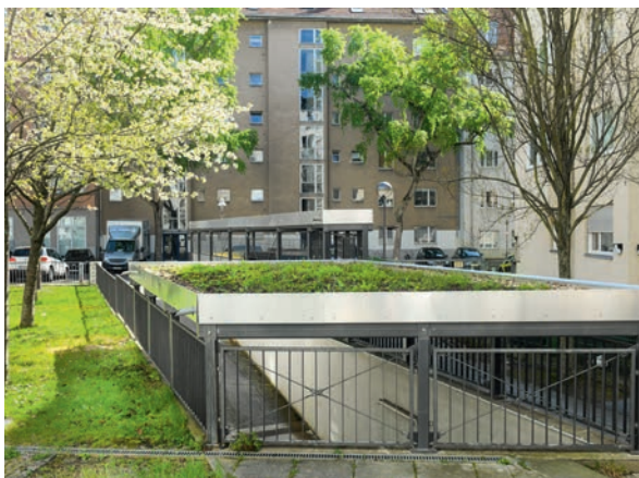
WIE 341 | Begrünte Tiefgaragenüberdachung am Kaiserdamm 97
