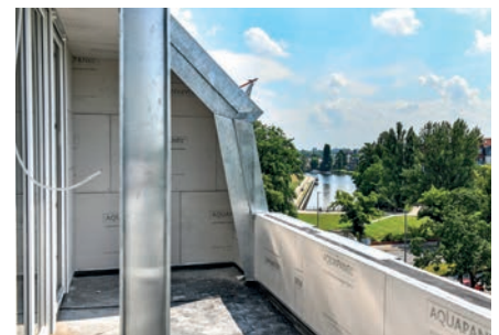
Blick von der neuen Dachterrasse © Tina Merkau
