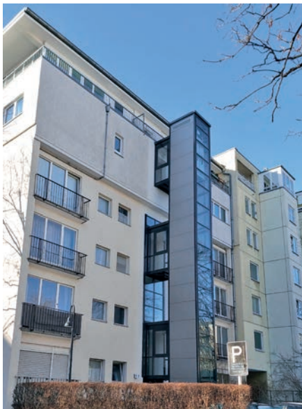
Abb. 3: Neuer Aufzug in der Kohlrauschstraße 1 © Thomas Weiser
