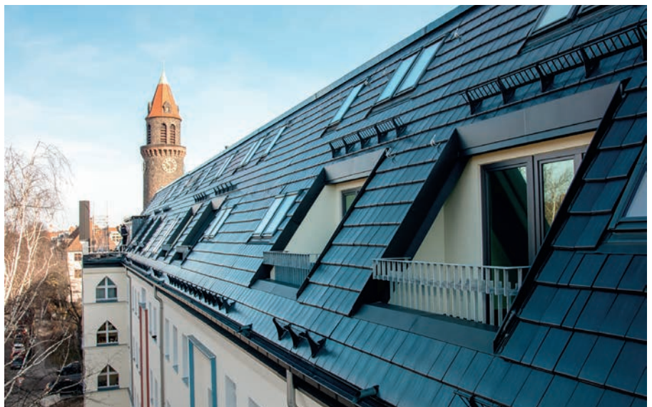
Abb. 5: Neues Dachgeschoss WIE 410B, straßenseitig © Max Oberüber
