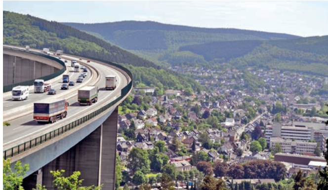
Siegtalbrücke mit der A45 mit Blick auf Eiserfeld © Eric Weber/Wikipedia
