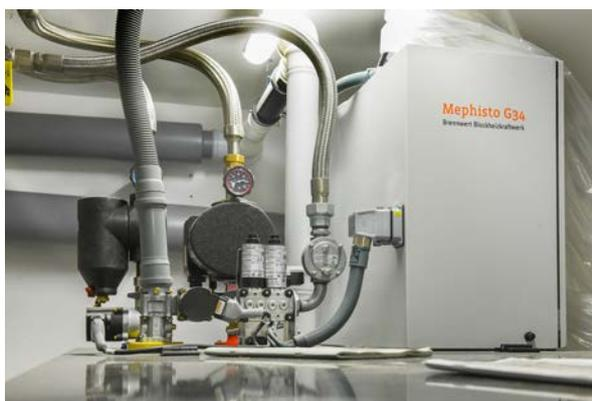
WIE 570/580 | neues Blockheizkraftwerk (BHKW)
