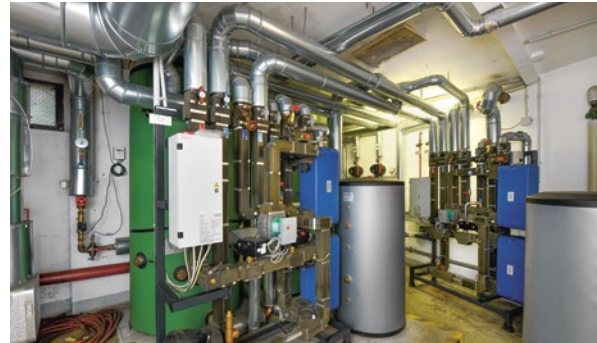
Neue Gaskessel für die WIEs 080-140 in Berlin-Hakenfelde
